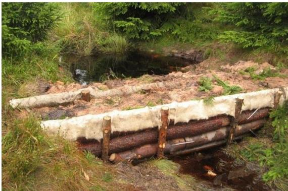
Abb. 14 Verfüllter Doppeldamm aus Rundholz
